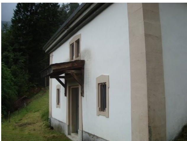
Illustration 2: Réservoir des Traversins
