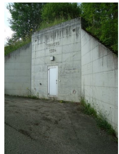
Illustration 22: Réservoir de Crépon
