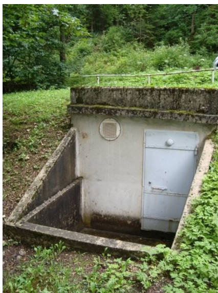
Illustration 8: Réservoir de la Raisse
