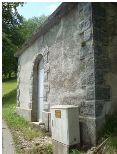
Illustration 9: Réservoir de Boveresse
