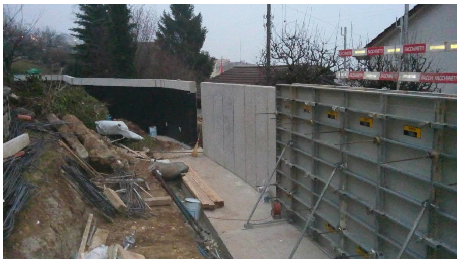
Figure 11: Construction d'un mur en béton armé (Source: VBI SA)
