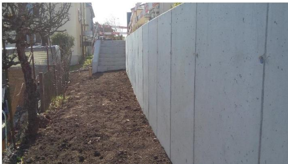
Figure 10: Mur en béton armé (Source: VBI SA)
