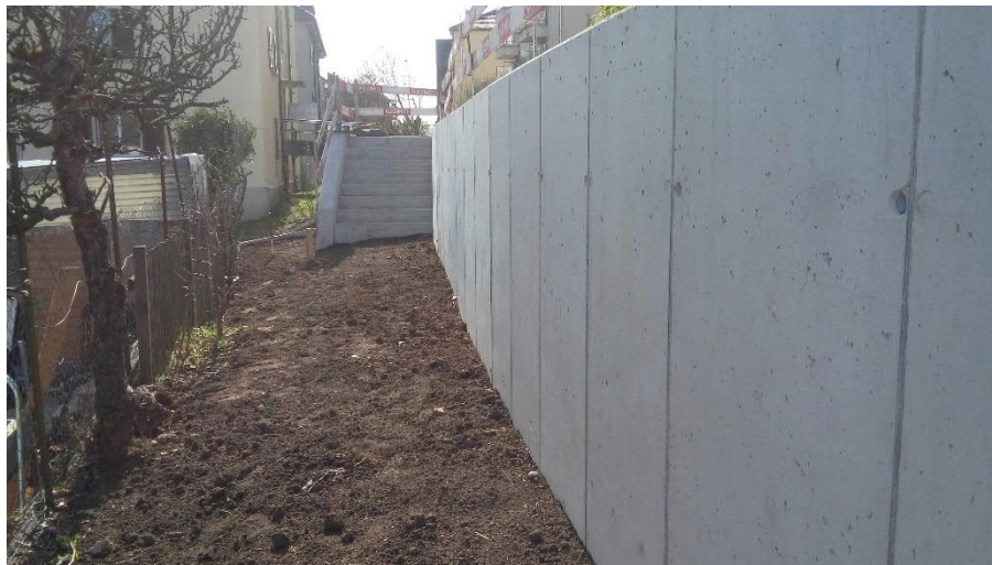
Figure 10: Mur en béton armé (Source: VBI SA)
