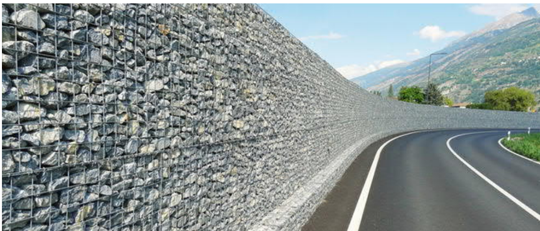
Figure 8: Exemple de mur en gabions (Source : SYTEC)
