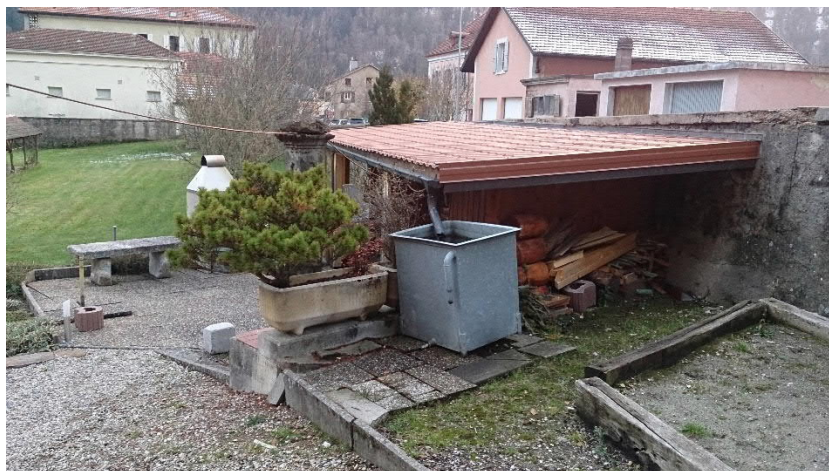
Figure 5: Couvert existant dans le bien-fonds 1128 (Source: VBI SA)
