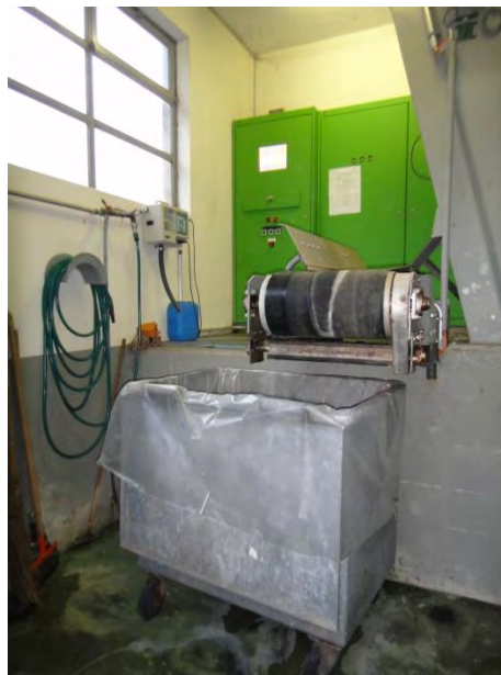
Remplacement du système de convoyage des déchets actuel (compacteur de déchets)
