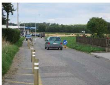
Figure 40 : bande longitudinale pour piétons avec poteaux en bois rétractables type « RWB », Fahys
