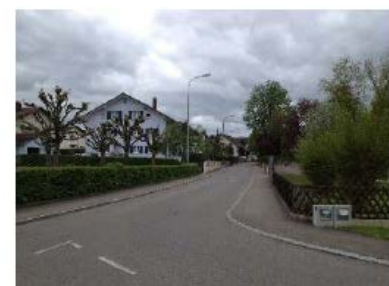
Figure 54 : Trottoirs, rue des Tilleuls à Porrentruy
