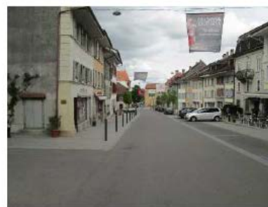
Figure 41 : poteaux métalliques, Avenches
