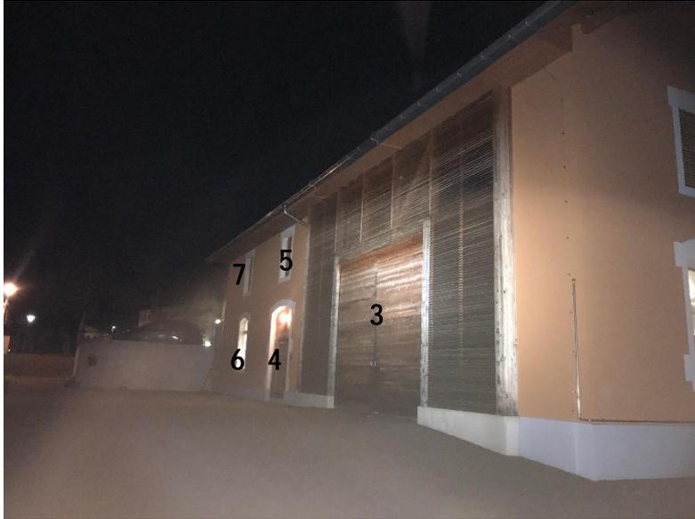
Points d'émission sur la façade. n°3 : grande porte, n° 4 petite porte, n°5 grille au-dessus de petite porte, n°6 fenêtre, n° 7 grille au-dessus de fenêtre
