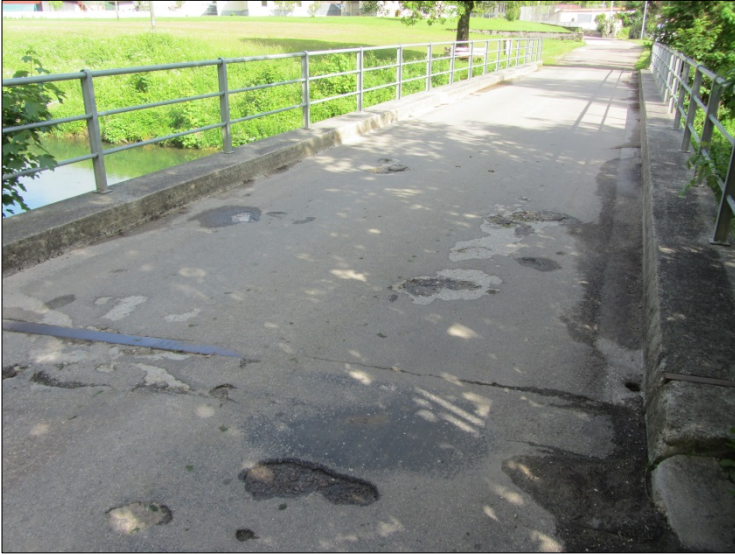
« Réparation » locale du revêtement sur une armature (nervurée) à nu
