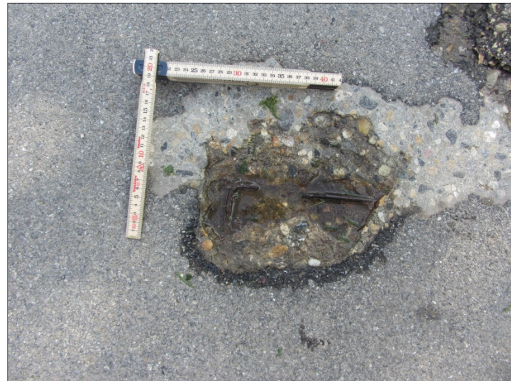
Fer rond à nu (étrier des poutres principales)
