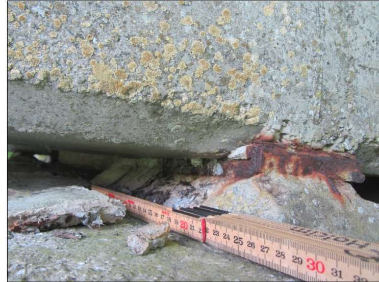
Culée Sud, côté amont (détail de la partie supérieure disloquée)
