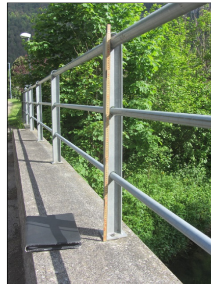
Détail du garde-corps (celui-ci n'est pas d'origine, plaque de base avec chevilles)
