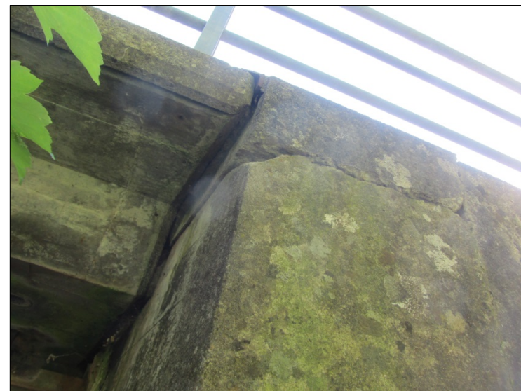
Culée Sud, côté amont (détail de la partie supérieure disloquée)
