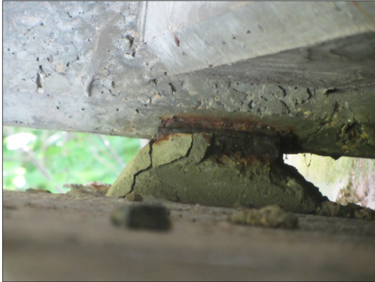
Culée Sud, côté amont (fissure, efflorescence et partie supérieure disloquée)
