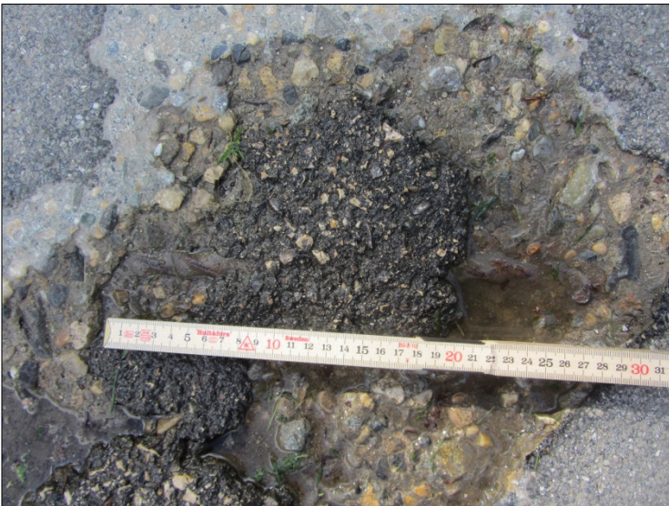
« Réparation » locale du revêtement sur une armature (nervurée) à nu
