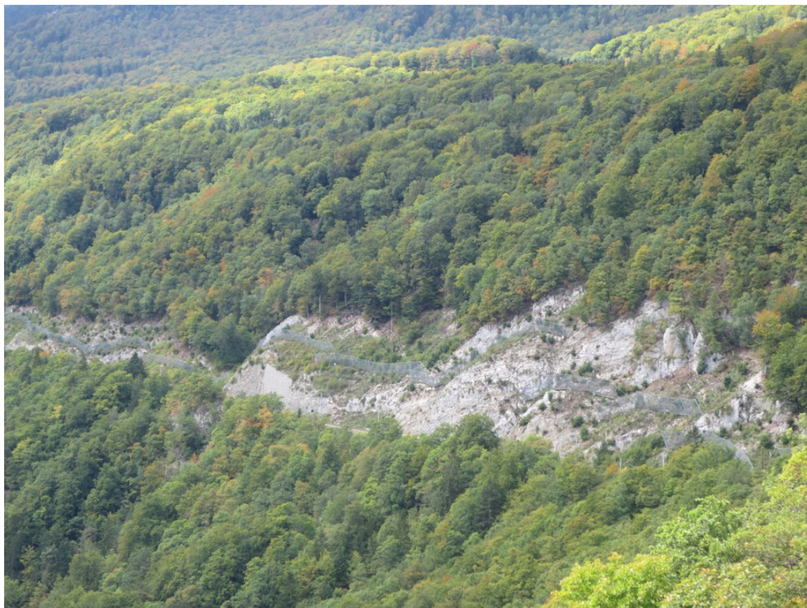
Image 1 : Ouvrages de protection à Champ-du-Moulin, 2 ans après les travaux, 15.09.2015
