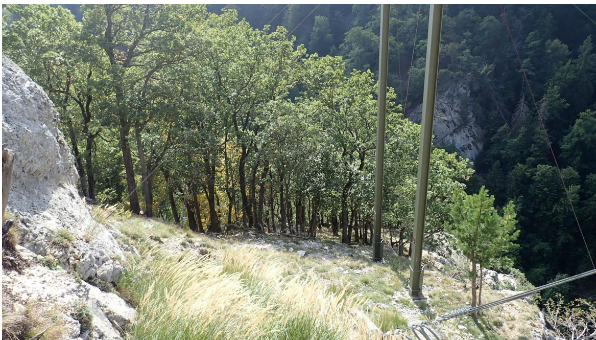
Image 6 : limite entre zone de travaux et forêt non touchée par les ouvrages de protection, 18.09.2019
