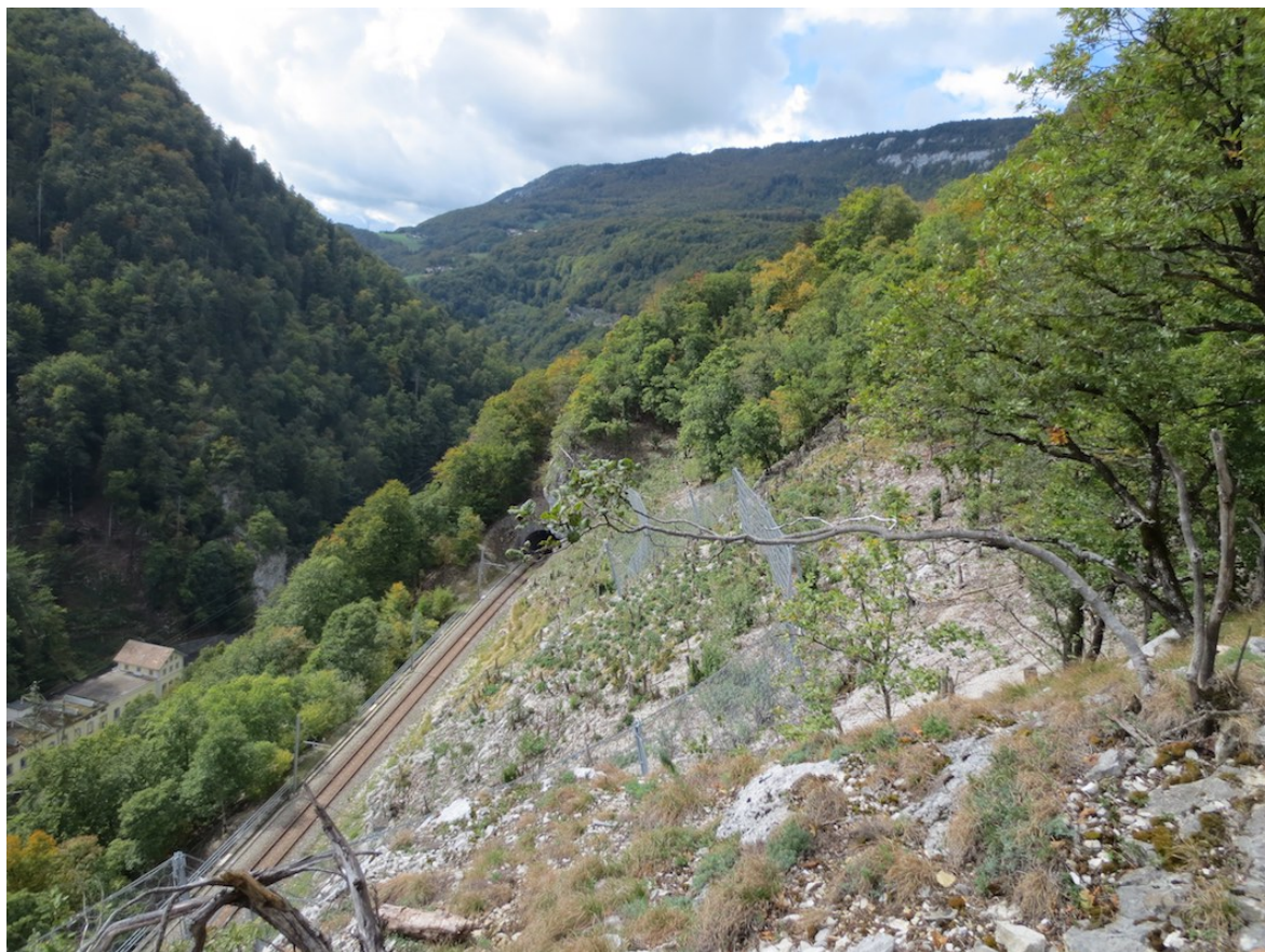
Image 3 : Ouvrage de protection à Champ-du-Moulin, 2 ans après les travaux, 15.09.2015
