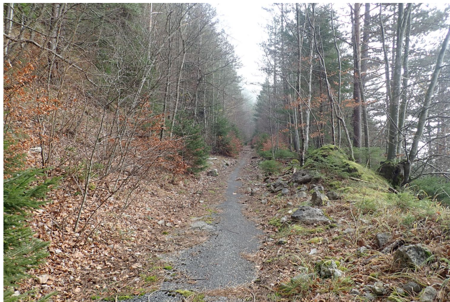
Ancienne route cantonale de la Clusette, 24 novembre 2020
