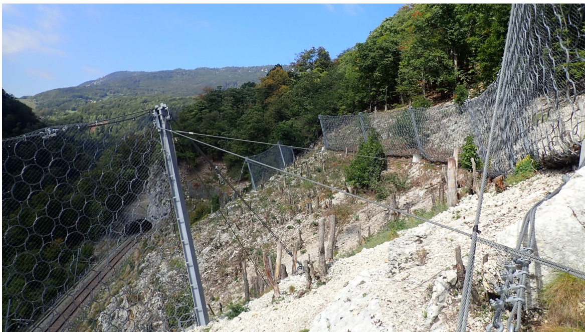
Image 5 : Ouvrages de protection à Champ-du-Moulin, 6 ans après les travaux, 18.09.2019
