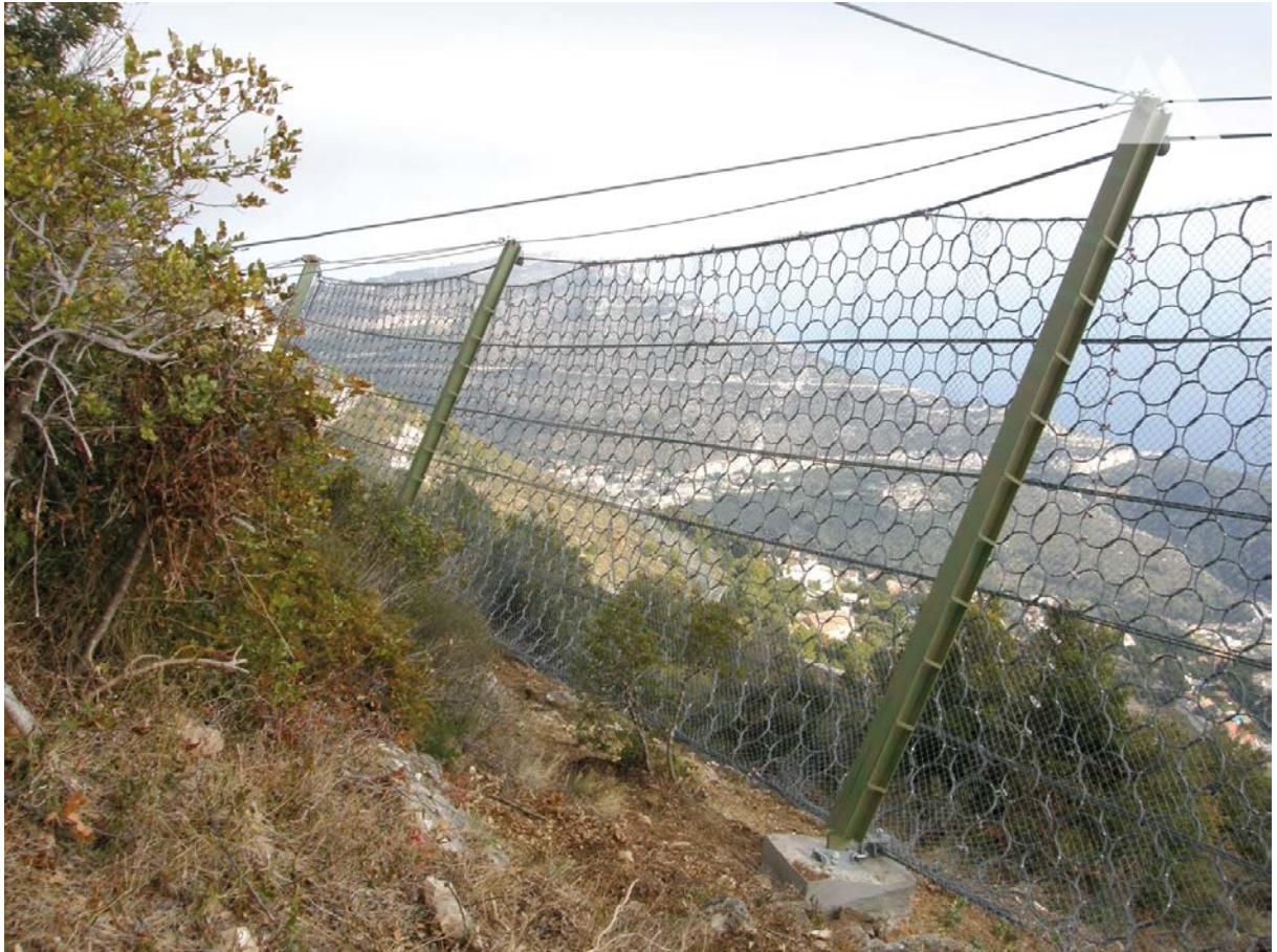
Fig. 5. Exemple de filet pare-pierres 5'000 kJ, hauteur 6 m (photo Geobrugg AG).
