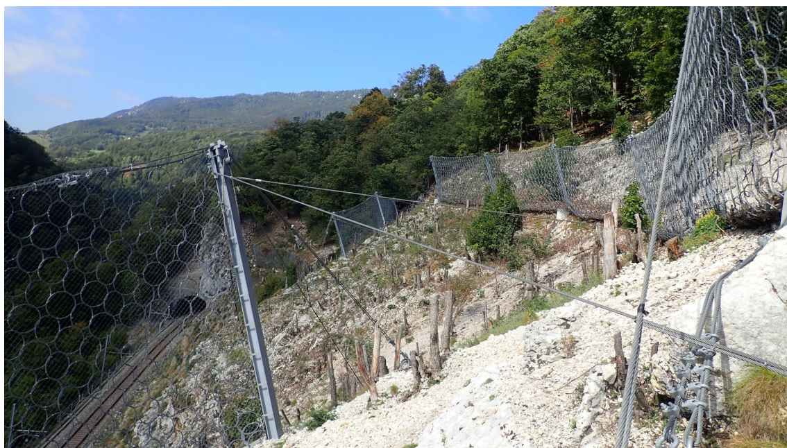
Fig 10 : Ouvrages de protection à Champ-du-Moulin, 6 ans après les travaux, 18.09.2019
