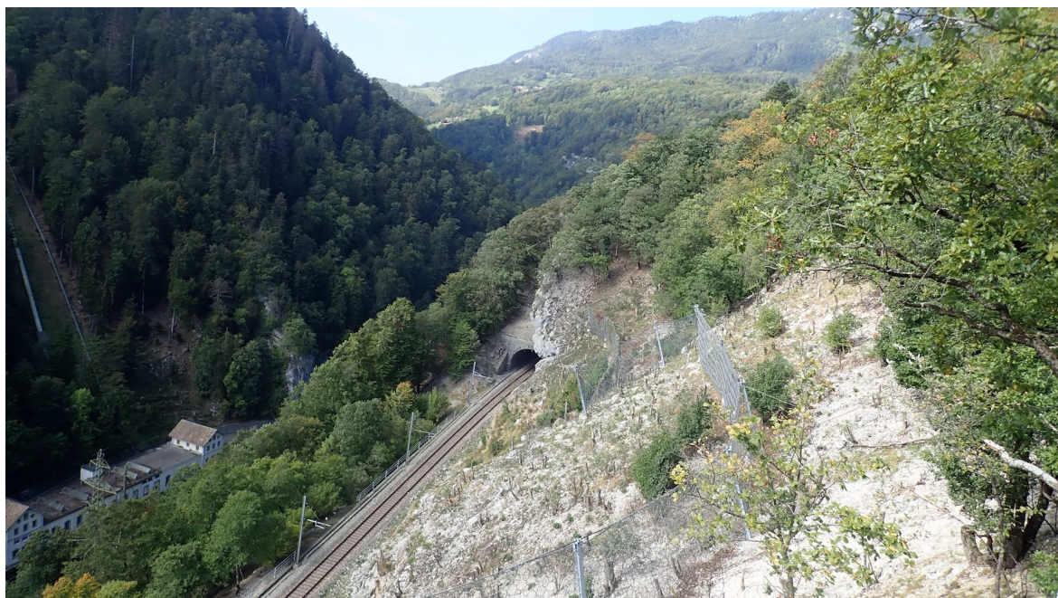
Image 4 : Ouvrages de protection à Champ-du-Moulin, 6 ans après les travaux, 18.09.2019
