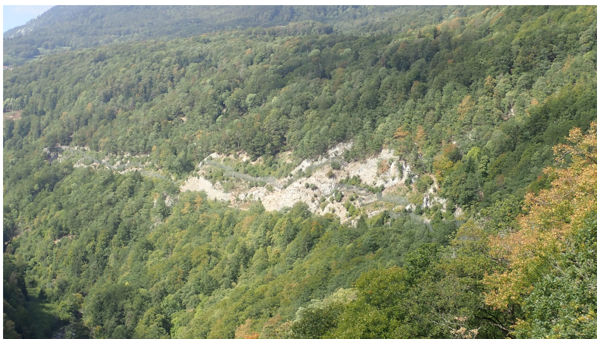
Image 2 : Ouvrages de protection à Champ-du-Moulin, 6 ans après les travaux, 18.09.2019
