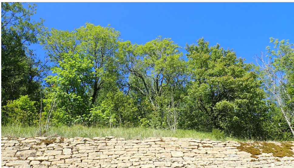
Emplacement de la digue au-dessus du mur au Furcil, vue depuis la route, 03.09.2019
