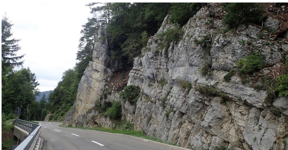
Emplacement treillis plaqué R-T3 Est, 02.09.2019
