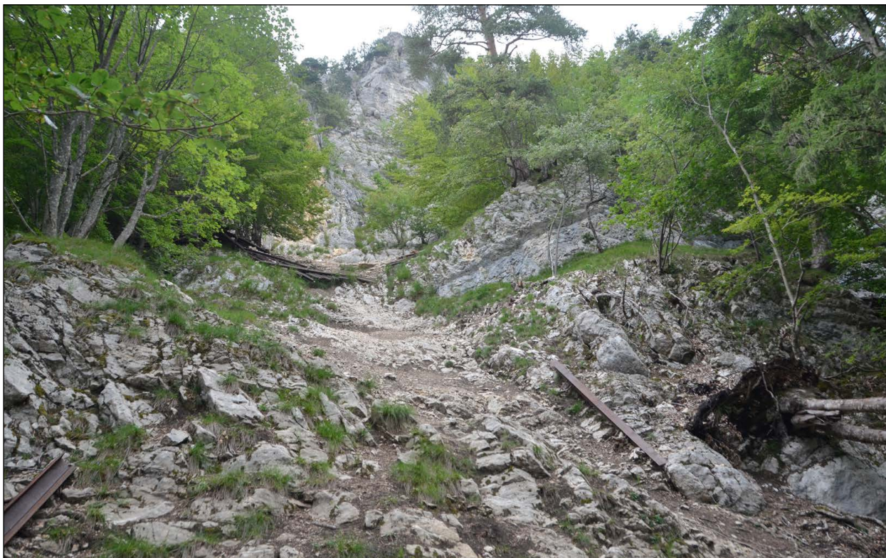
Secteur G: instable, la zone a subi un éboulement important il y a quelques années.
