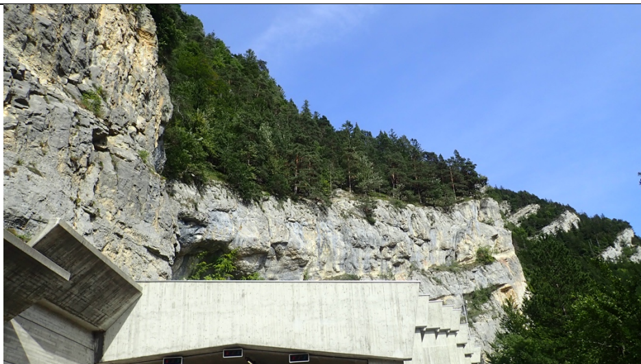
Emplacements des ouvrages H-C4, 15, 16, 17, 10.09.2019
