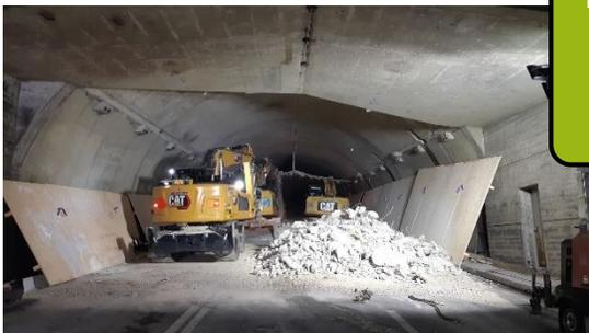
Démolition de la dalle de ventilation du tunnel
